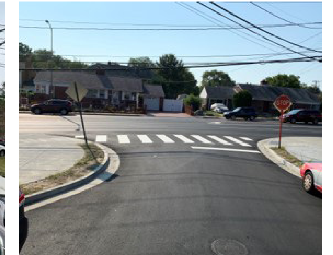
Verano 2019: mejora del pavimento
